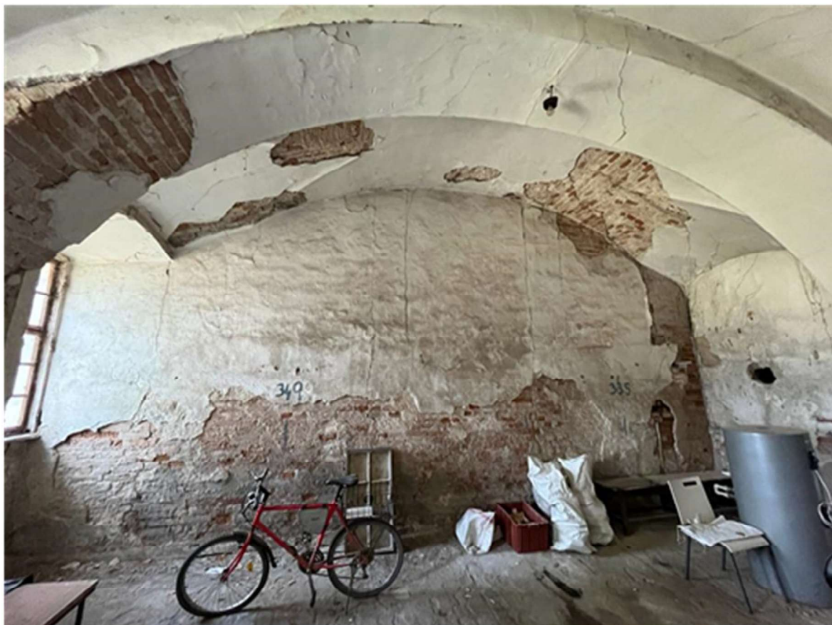
Místnost č. 1.02 Technická místnost – trhliny v klenbách tloušťky do 5 mm, celková délka 6,0 m. Trhliny ve stěnách tloušťky do 5 mm, celková délka 3,0 m.
