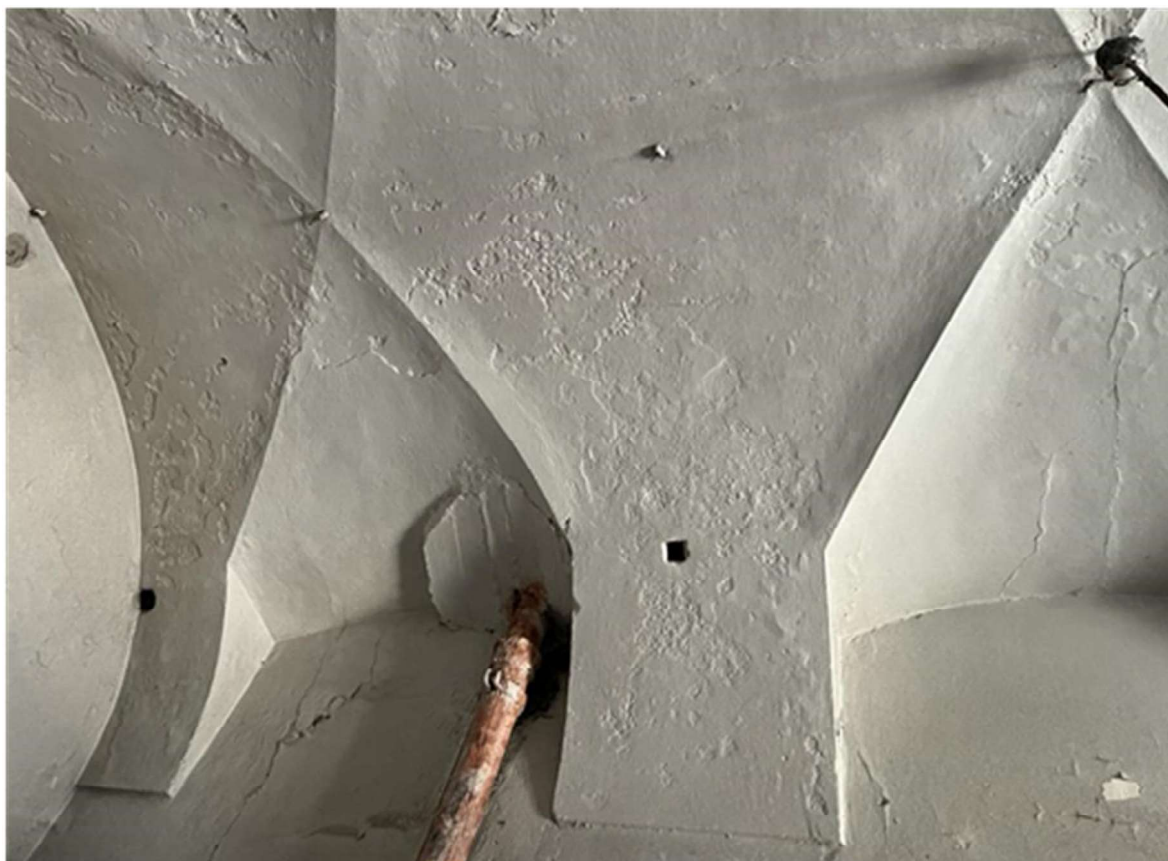
Místnost č. 1.02 Technická místnost – trhliny v klenbách tloušťky do 5 mm, celková délka 6,0 m. Trhliny ve stěnách tloušťky do 5 mm, celková délka 3,0 m.
